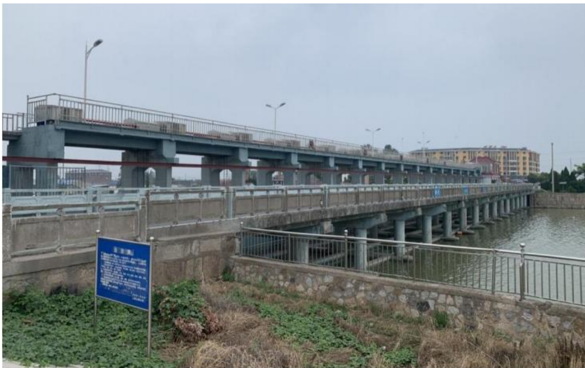
图 4.1-3 运棉河闸现状图
